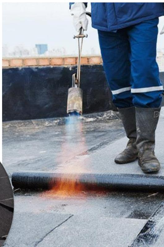
La instalación de la membrana se realiza con soplete (colocando calor a la membrana) asegurando la mayor adherencia entre la membrana y la superficie.
