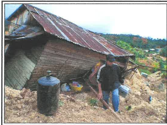
Foto 7.4.1.1.6.1-1. Vivienda destruida por corrimiento de tierra.
