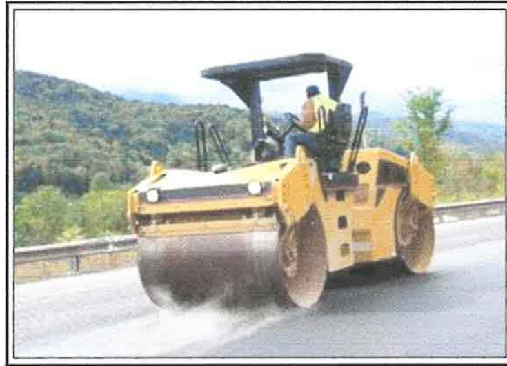
Foto 4.4.3.2-2. Equipos utilizados en el proyecto.
