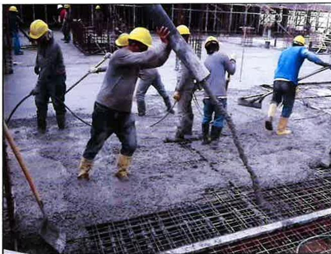
Los agregados grueso y fino para la elaboración del hormigón cumplirán las especificaciones para materiales de la norma ASTM C-33.
