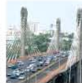
El renovado puente Juan Bosch fue entregado ayer.
