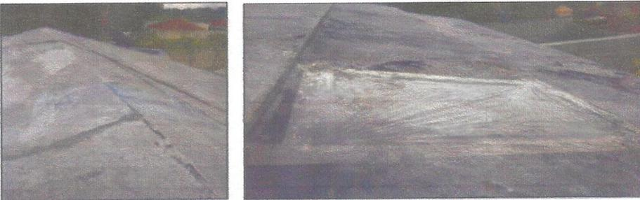
Prueba de humedad por el método del plástico, norma ASTM D-4263-83.
