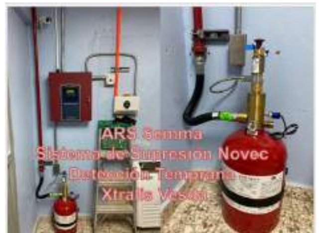
Teleperformance Sistema de Supresión con Novec Xtralis Vesda detección Temprana
