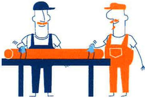
**Paso 3:** Medir la profundidad de la campana, esta medida se marca en el extremo del tubo, esto con el fin de verificar la profundidad de inserción y aplicar la cantidad de cemento solvente adecuado.
