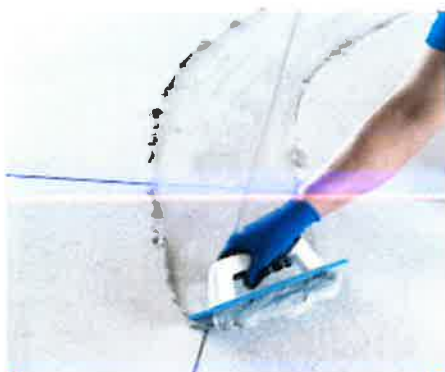
Rejuntado de revestimiento de mosaico vítreo (en baño) con llana
