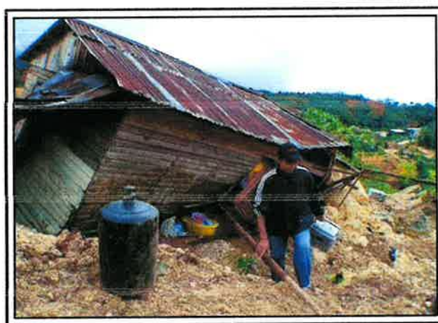
Foto 3.2.1.1.6.1-1. Vivienda destruida por corrimiento de tierra.
