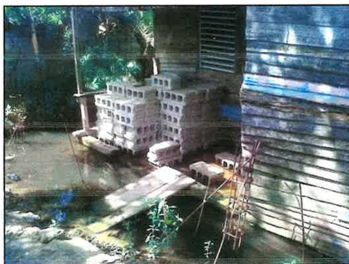
Foto 3.21.1.3-1. Viviendas inundadas en El Javillar.
