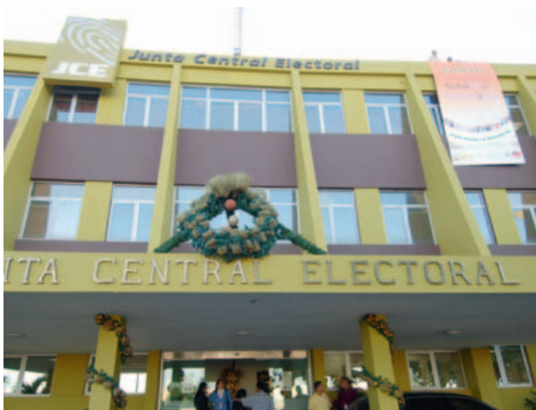
Bajante colocado en la parte frontal del edificio sede de la JCE.
