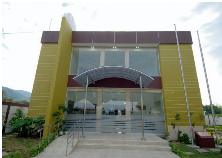
Fachada principal del edificio de Tábara Arriba.
