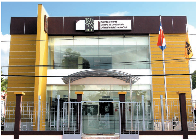
El nuevo local de la JCE en Jaragua donde funcionarán la Oficialía del Estado Civil, un Centro de Cedulación y la Junta Municipal Electoral.
