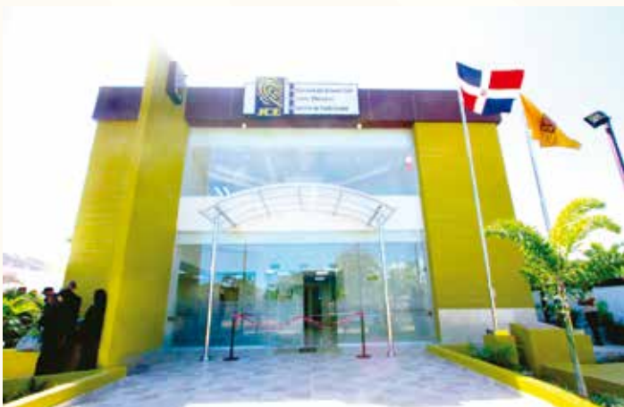
Vista parcial del nuevo edificio JCE en Sabana de la Mar
